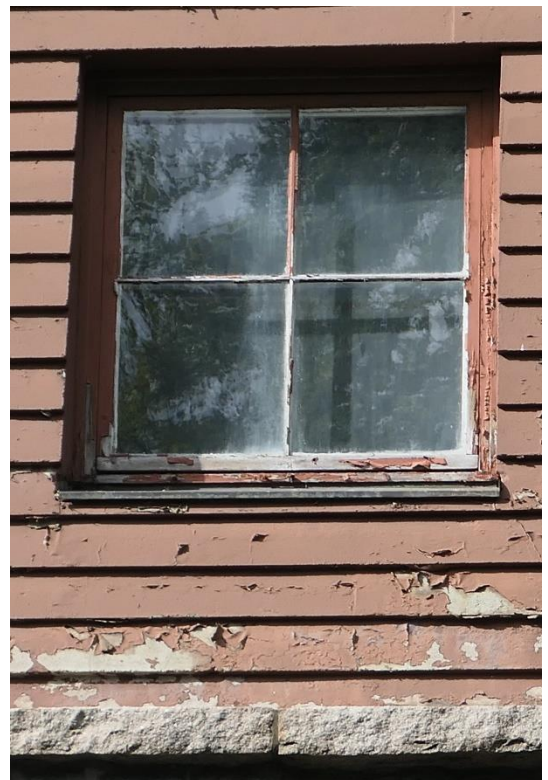
Originalt vindu med sprossekryss t.h. for taknedløp. Gesimsbånd av granitt.
