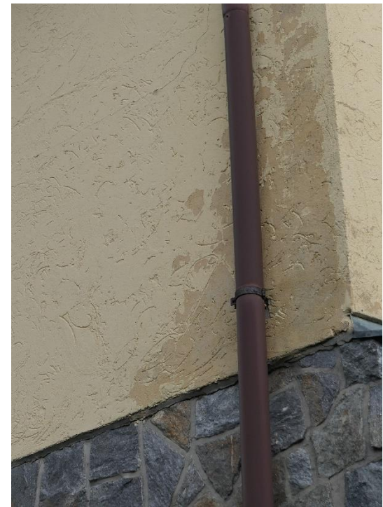
Detalj av fløyens pussoverflate, hushjørnet fra bildet t.v.
