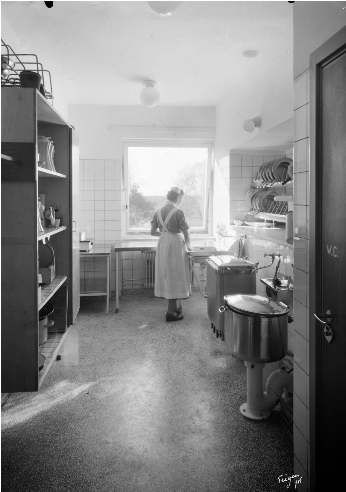
Sykehuset representerte en formidabel standardheving da det sto ferdig i 1952. Her fra et vaske-/spylorom med bekkenvaskemaskin, flislagte vegger og terrazzo på gulvet. Foto: Teigen
