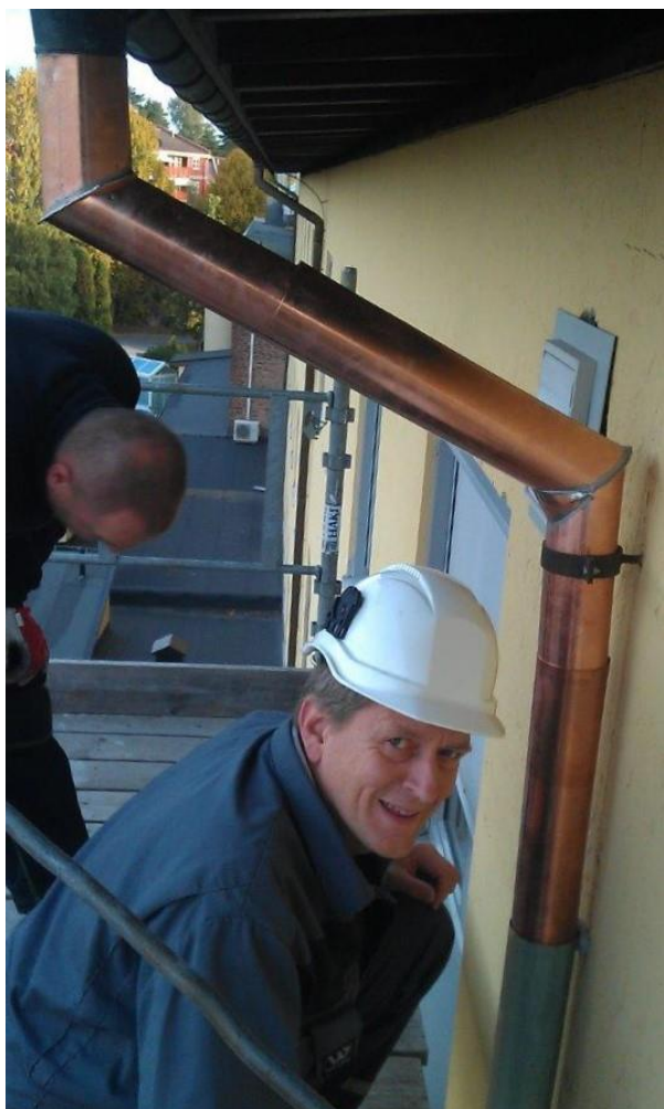
Vedlikeholdsleder Svein Arne Jakobsen i arbeid med nytt kobbernedløp – med tradisjonelle skarpe bend – i 2013. Foto fra SØHF
