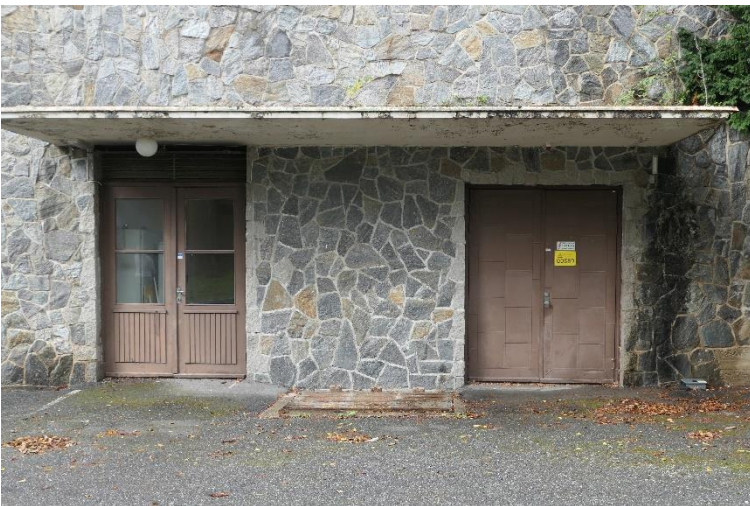
Østvegg, opprinnelige dører under baldakintak. Veggen har bruddstensforblending.
