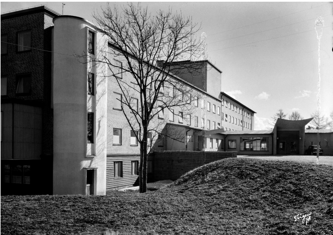
Sykehuset sett fra norvest, med ambulanseinngang (revet) og hovedinngang. Ant. 1952. Foto: Teigen
