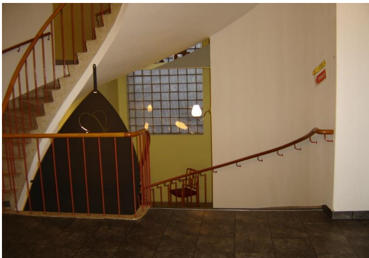
Trapperom i 1. et. med «seil» som skal hindre ulykker.
