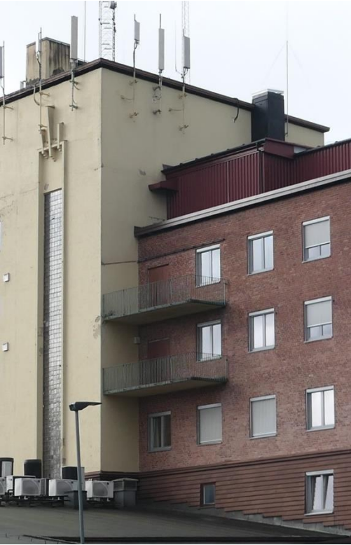
Opprinnelige balkonger på nordfløy mot trappetårn. Armert betong, spilerekkverk.
