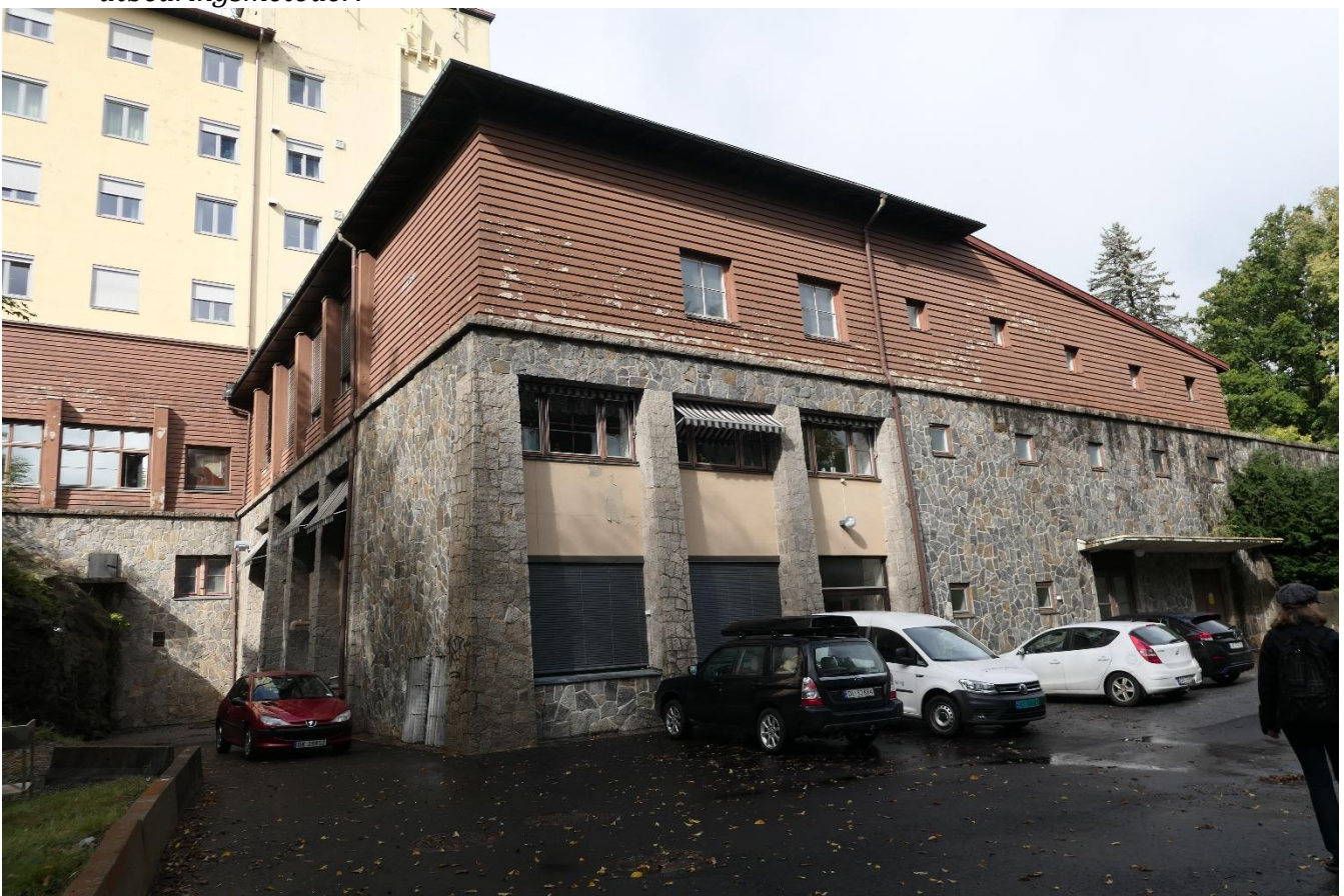
Sykehusets sokkeletasje har for en stor del forblending av bruddstein på betongmurene. Her er muren gitt skikkelse av kontreforter, dvs. tverrstilte støttmurer, slik man finner det bl.a. på Fredriksten festning.
