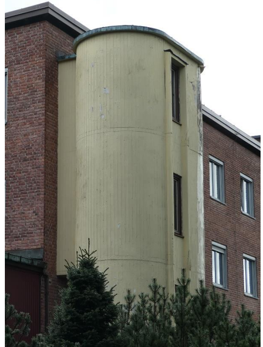
Detalj av silotrapp med bølgeformer i forskalingsavtrykket
