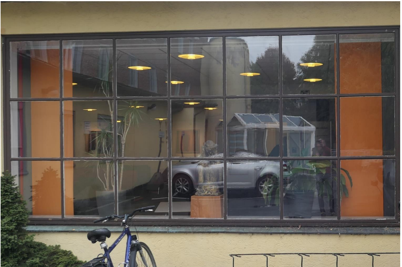
Vindusfelt mot vestibyle, til side for pasientinngang. Tradisjonelt trevindu med glass lagt i kittfals.
