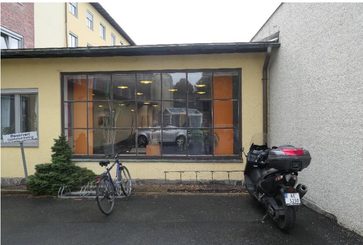
Opprinnelig, sprosdedelt vindu t.v. for inngangspartiet.
