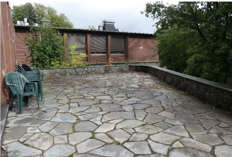
Terrassedekke av villskiferheller.
