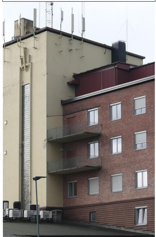
Detalj av overgangen mellom nordfløy og trappetårn. Originale balkonger.
