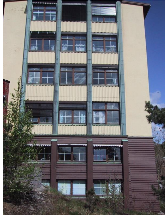
Sydvegg før skifte av vinduer i 2001. Foto: ukjent
