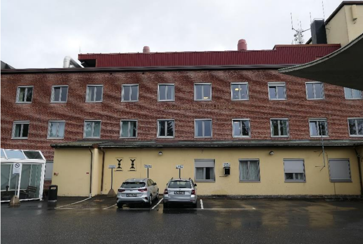
Del av nordfløyens vestfasade, med tidligere (gjenstøpt) ambulanseinngang og stort teknisk rom på taket.
