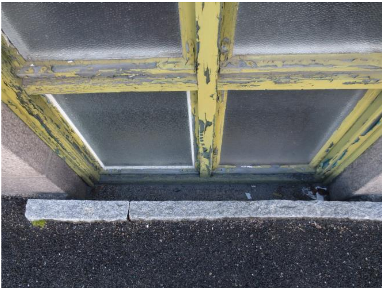
Opprinnelig kjellervindu av tre på annet byggetrinn, med nyere kantsten mot asfalt.
