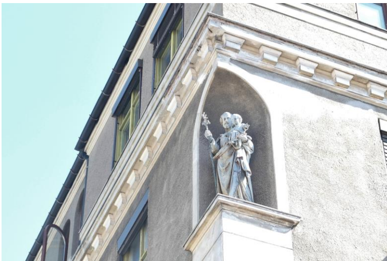
Detalj av St. Joseph med barnet-statuen på bygningens hjørne. Bildet tatt i 2020 (foto: H.-H. Egede-Nissen)
