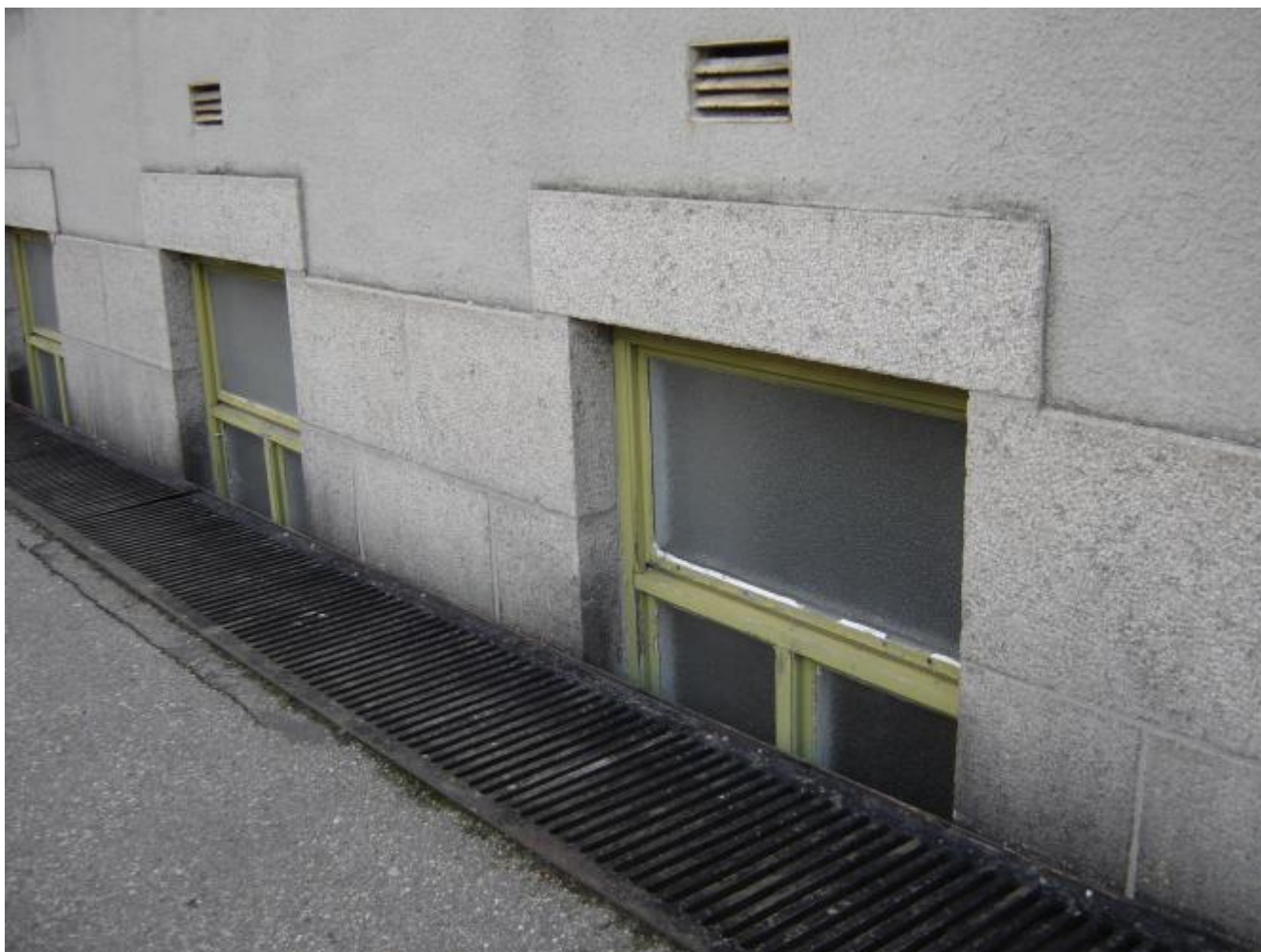
Over: Kjellervinduer på sørfasaden, disse er forblendet med granitt. Forblending er ikke-bærende murverk, som veggkledning utenpå et annet materiale, her på plasstøpt betong (i grunnmur). Foto fra SØHF
