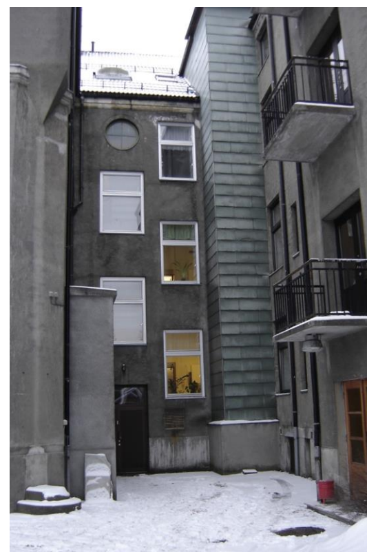
Del av hovedvolumets gårdsfasade, med operasjonsfløyen t.v. (Fotograf ukjent, bilde fra SØHF)
