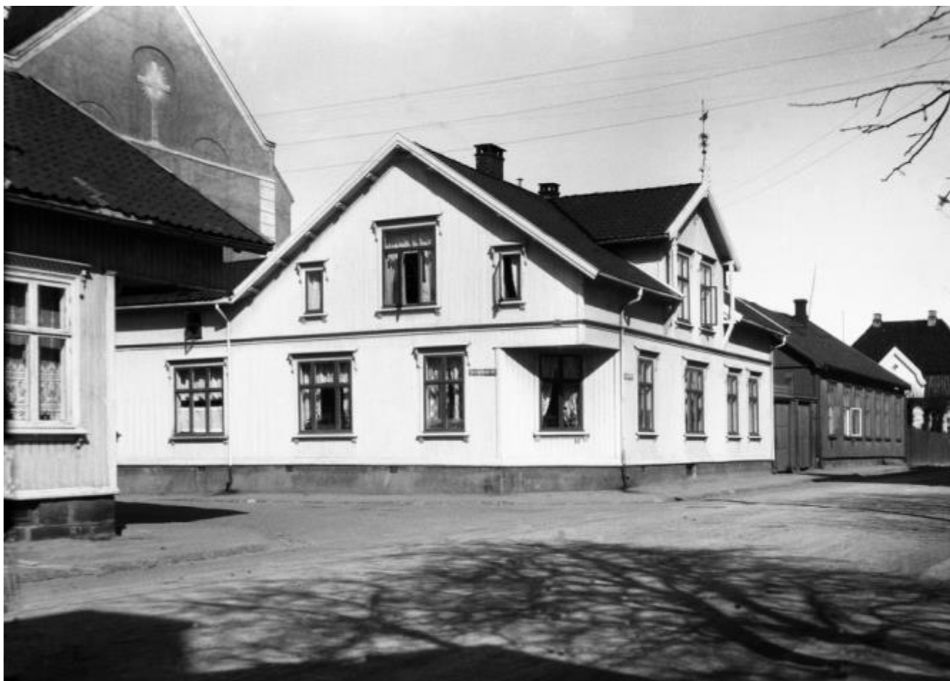
Over: Gavlvegg mot øst (idag forblendet av fjerde byggetrinn) ses her t.v. i bildet. (fotograf og eier ukjent)
