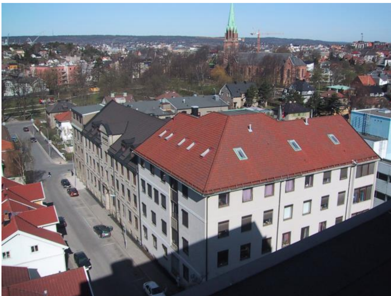
Over: Flyfoto av St. Josephs hospital. Taket på første byggetrinn har mørk taksten, mens takene på annet og tredje byggetrinn er tekket med papp. I forgrunnen byggetrinn 4 fra 1965 (ikke vernet). Foto fra SØHF
