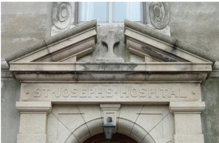
Detalj av portal. (Fotograf ukjent, bilde fra SØHF)
