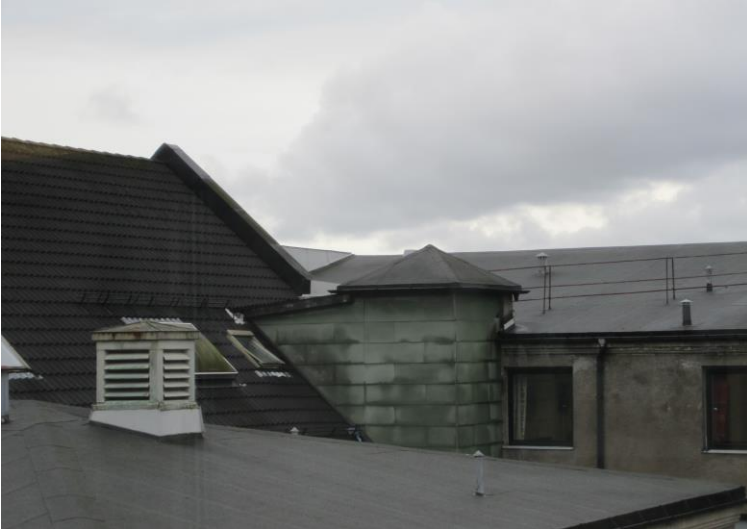
Møtet mellom byggetrinn 1 (t.v., stopper ved gavlen) og 2 (t.h. for dette). Heis-/ventilasjonsjakt kledd med eternitplater. (Fotograf ukjent, bilde fra SØHF)
