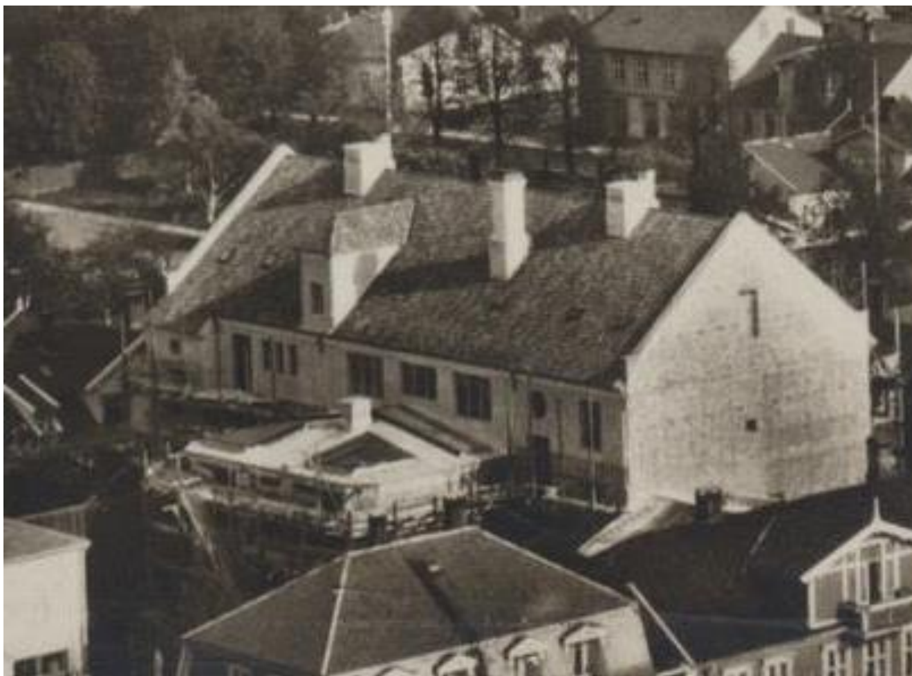
Over: Første byggetrinn under oppførelse. Her ses de opprinnelige takvinduerne over operasjonssalene i operasjonsfløyen, opprinnelige loftsvinduer og opprinnelig plassering av vinduene i nordfasadens vestre del. (Fotograf: Anton Olsen Eier: Østfold fylkes billedarkiv)
