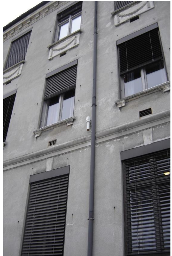
Fasadeutsnitt med vinduer, festonger, taknedløp, solavskjerming. (Fotograf ukjent, bilde fra SØHF)
