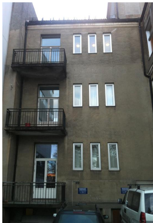
Del av hovedvolumets gårdsfasade, med operasjonsfløyen t.h. (Fotograf ukjent, bilde fra SØHF)
