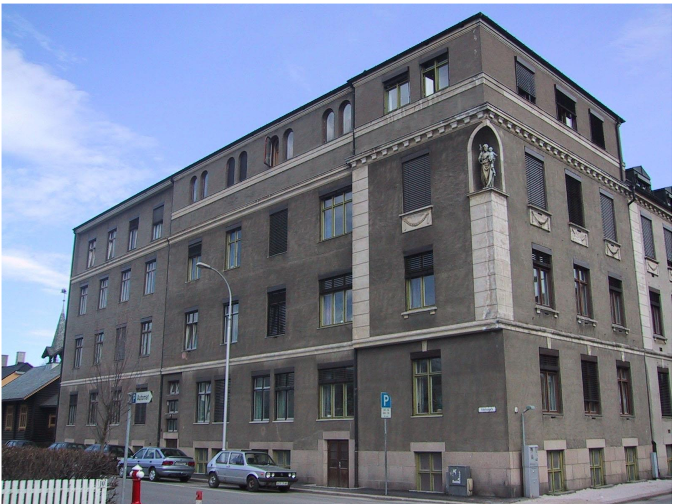
Annet byggetrinn, fasade mot øst (Ridehusgaten). Volumet med de fire vindusaksene lengst t.v. er byggetrinn 3 fra 1954, som ikke omfattes av vern. (Fotograf ukjent, bilde fra SØHF)
