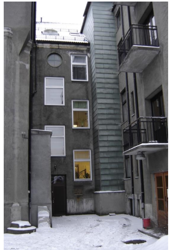
Veggen rett frem tilhører byggetrinn 1, mens 2. byggetrinns fasade skimtes bak balkongene. (Fotogr. ukjent, bilde fra SØHF)
