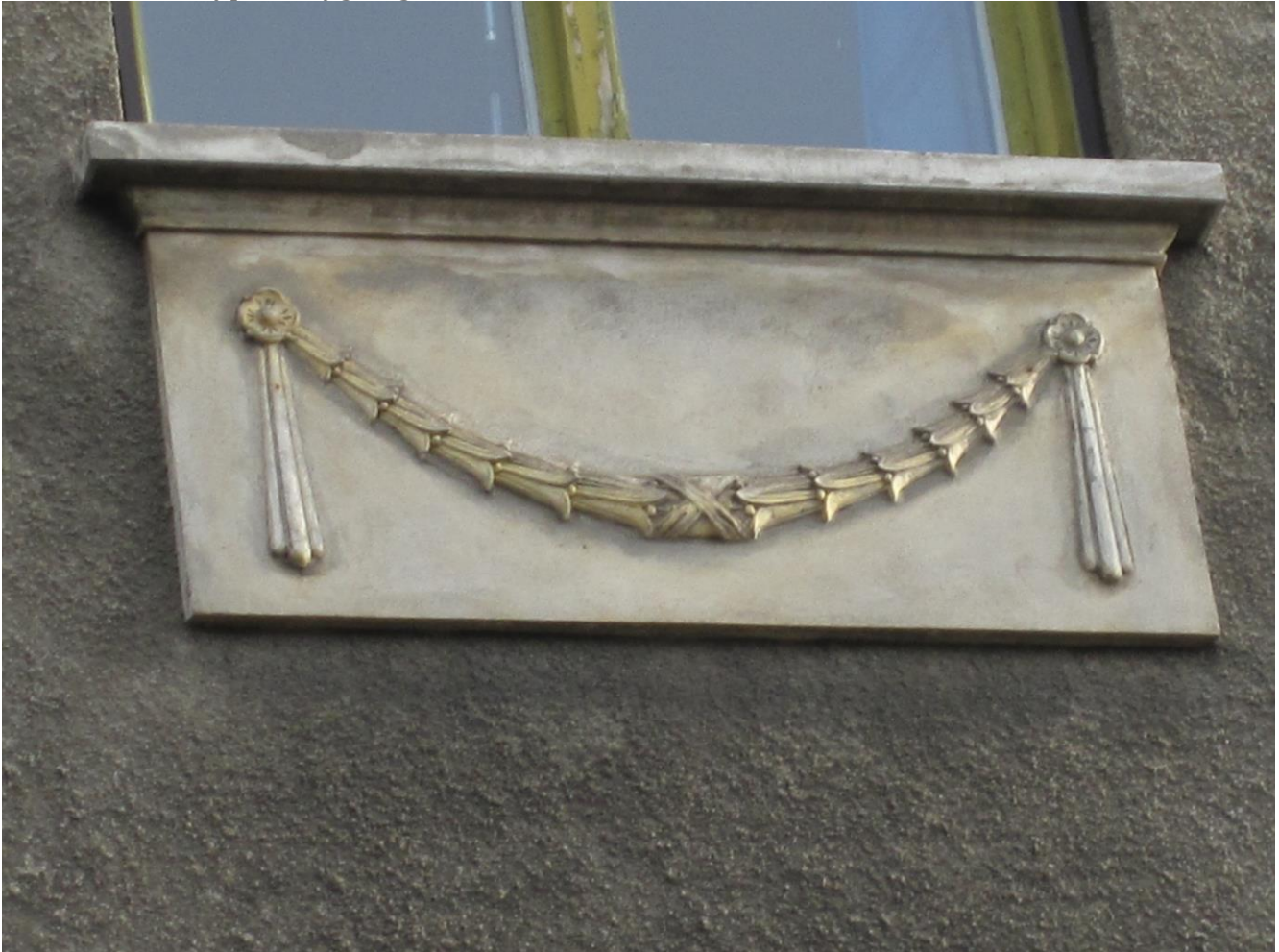
Over: Vestfasaden av annet byggetrinn, fasade av pusset tegl, støpt sålbenk, festong utført i stukk. (Ukjent fotograf, foto fra SØHF)
