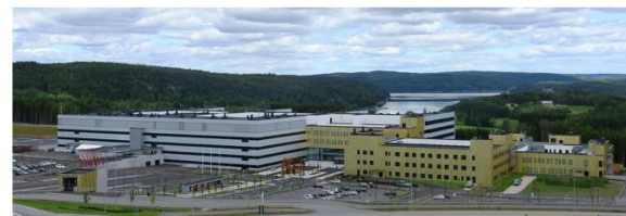
Sykehuset Østfold Kalnes
